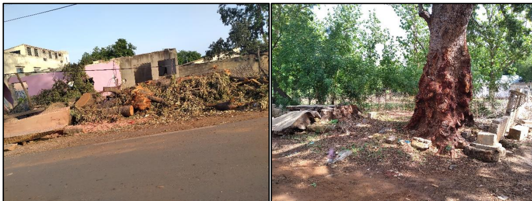
Photo 2 : Dégâts occasionnés par les arbres sur la route de Marsassoum
