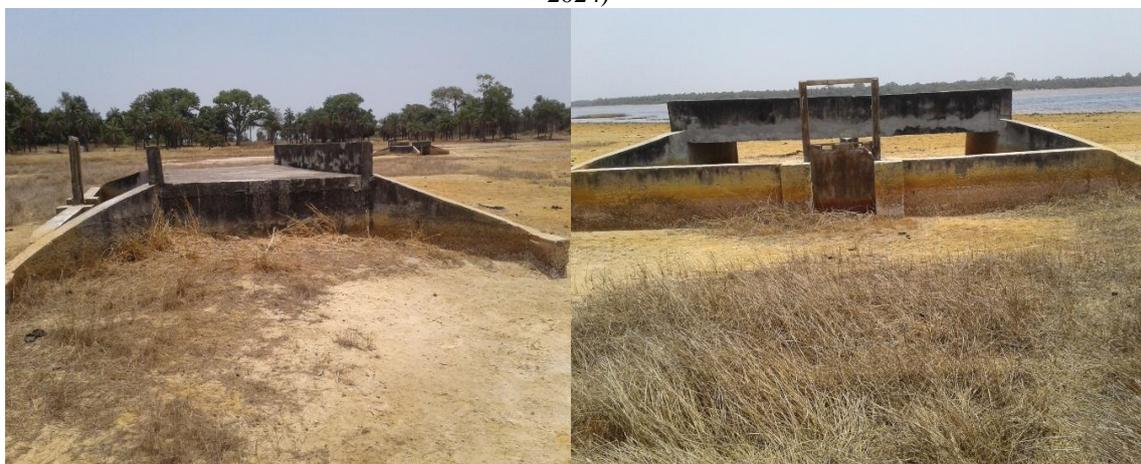
**Planche 9** : barrage abandonné par manque de renouvellement de la Digue à Karongue (Cliché Sané, 2024)
