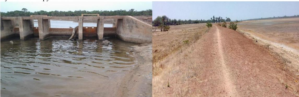
**Planche2:** quelques méthodes de lutte mécanique dans le bassin versant de Diouloulou : endiguement et micro-barrage (Cliché Sané, 2023)
